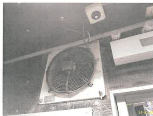
พัดลมระบายอากาศ และไฟส่องสว่างฉุกเฉิน
